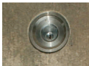
Abb. 10 In die Wand eingelassener »Safe« zur Aufbewahrung des Schlüssels zum Hausanschlussraum
